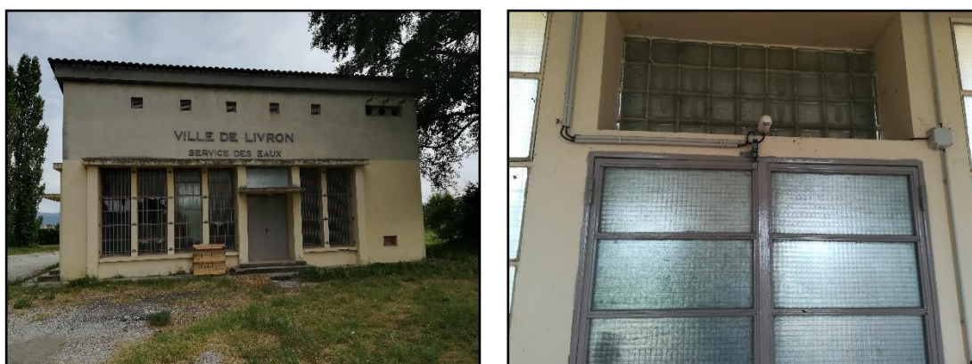
Figure 6 : Photographie de l'accès au local (gauche) et de l'alarme anti-intrusion (droite)
